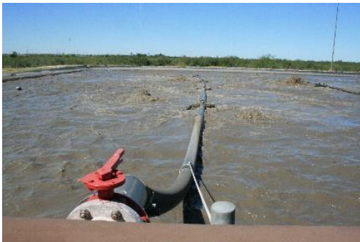
REACTOR BIOLÓGICO. SE APRECIAN EL PASO DEL LICOR MEZCLADO AL SEDIMENTADOR SECUNDARIO.
