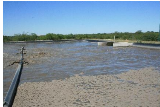
REACTOR BIOLÓGICO. SE APRECIAN EL PASO DEL LICOR MEZCLADO AL SEDIMENTADOR SECUNDARIO.
