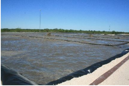
REACTOR BIOLÓGICO. SE APRECIAN FALLAS EN EL SISTEMA DE DIFUSORES.
