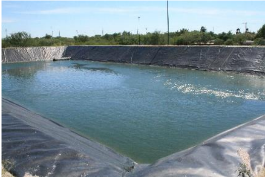
SISTEMA DE DESINFECCIÓN: CASETA DE CLORACIÓN Y LAGUNA DE CONTACTO DE CLORO.
