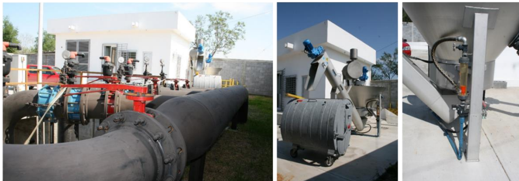
(IZQ) MÚLTIPLE DE DESCARGA DE AR AL SISTEMA LAGUNAR. (DER) DESARENADOR CENTRÍFUGO DE AR.
