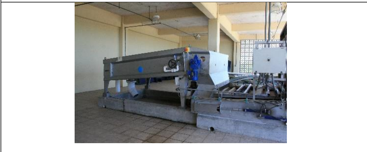
SISTEMA DE DESAGUADO MECÁNICO DE LODOS. SE APRECIA LA MESA VIBRATORIA PARA EL ESPESAMIENTO DE LODOS Y EL FILTRO BANDA.
