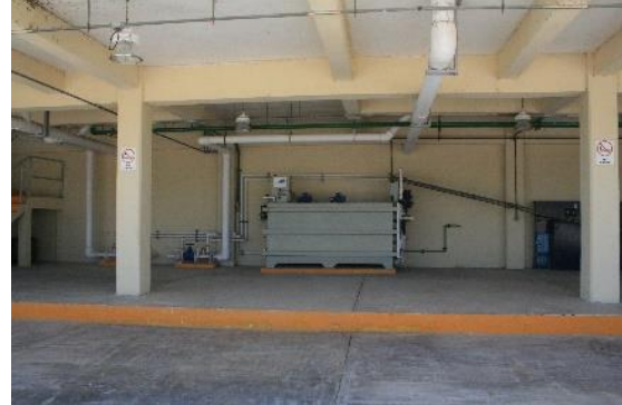
SISTEMA DE DESAGUADO MECÁNICO DE LODOS, MEDIANTE FILTROS BANDA.
