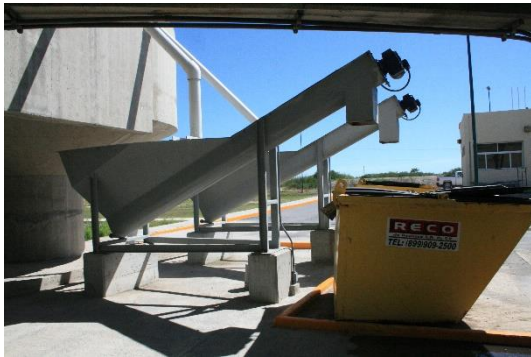
CLASIFICADOR DE ARENAS Y MATERIAL COLECTADO
