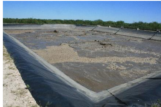
LAGUNA DE DIGESTIÓN AERÓBICA DE LODOS. SE APRECIA LA TUBERÍA DE DESCARGA A LAS LAGUNAS DEL SISTEMA FUERA DE OPERACIÓN.
