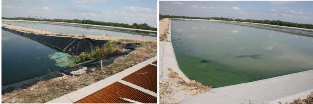
VISTA PANORÁMICA DE LAS LAGUNAS DE MADURACIÓN. (IZQ) SE APRECIA UNA ZONA DE BAJA VELOCIDAD DEL AGUA Y CRECIMIENTO DE MALEZA ACUÁTICA. (DER) AL FONDO SE APRECIA EL CÁRCAMO DE BOMBEO DE ART.
