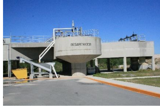
PRETRATAMIENTO DE CRIBADO Y DESARENADO.
