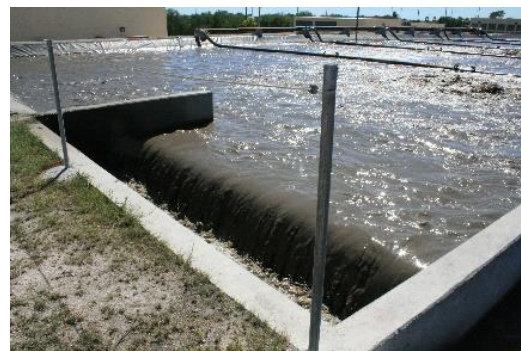
REACTOR BIOLÓGICO Y SEDIMENTADOR SECUNDARIO
