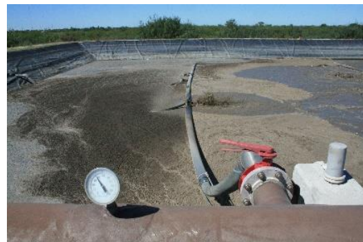
LAGUNA DE DIGESTIÓN AERÓBICA DE LODOS. SE APRECIA LA TUBERÍA DE DESCARGA A LAS LAGUNAS DEL SISTEMA FUERA DE OPERACIÓN.
