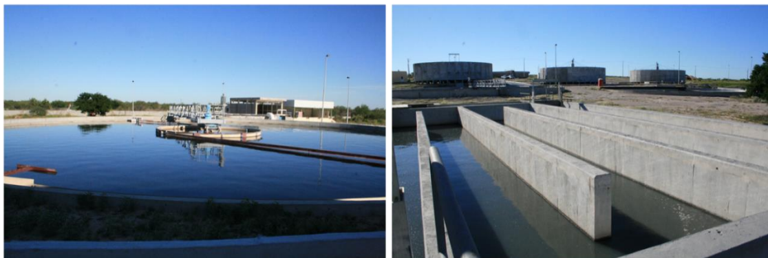
(IZQ) SEDIMENTADOR SECUNDARIO. (DER) TANQUE DE CONTACTO DE CLORO.
