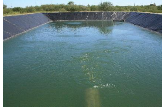
SISTEMA DE DESINFECCIÓN: CASETA DE CLORACIÓN Y LAGUNA DE CONTACTO DE CLORO.
