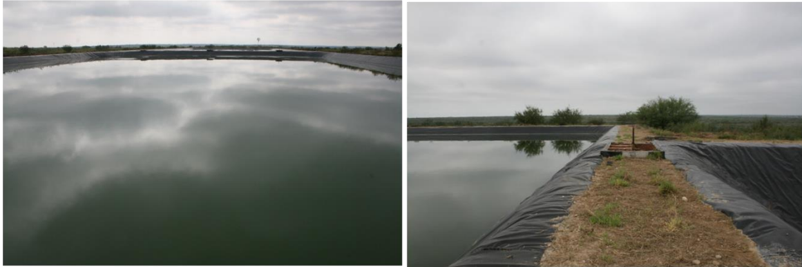
(IZQ) LAGUNA FACULTATIVA. (DER) LAGUNA DE MADURACIÓN
