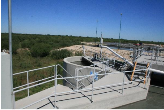
DESARENADOR CENTRÍFUGO
