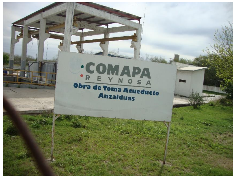
Figura 306. Obra de toma del Acueducto Anzalduas, Reynosa
