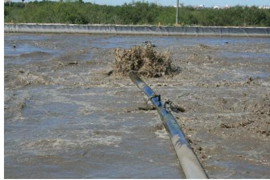
REACTOR BIOLÓGICO. SE APRECIAN FALLAS EN EL SISTEMA DE DIFUSORES.
