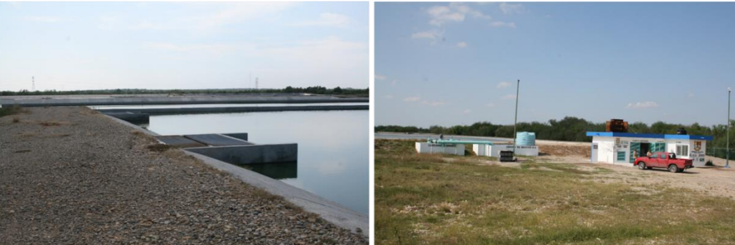
(IZQ) SALIDA DE LAS ART DE LA LAGUNA DE MADURACIÓN. (DER) CÁRCAMO DE BOMBEO DE ART Y CASETA CON EL EQUIPO DE MEDICIÓN DE CAUDALES.
