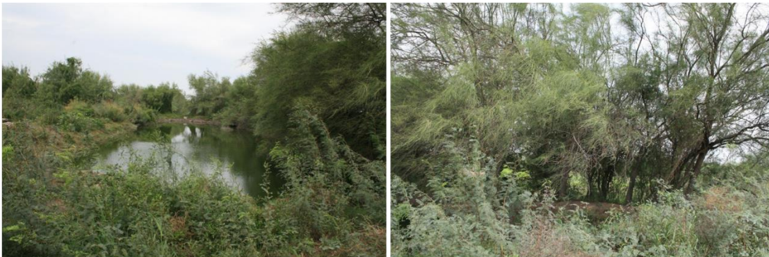
LA GRAN CANTIDAD DE VEGETACIÓN Y LA FALLA EN LA IMPERMEABILIZACIÓN DEL FONDO DE LAS LAGUNAS ANAEROBIAS, FACULTATIVAS Y DE MADURACIÓN IMPIDE LA DESCARGA DE AGUAS RESIDUALES TRATADAS. EL BALANCE DE PÉRDIDAS ENTRE LO QUE SE CONSUME POR LA VEGETACIÓN Y LO QUE SE INFILTRA NO SE HA ESTABLECIDO.
