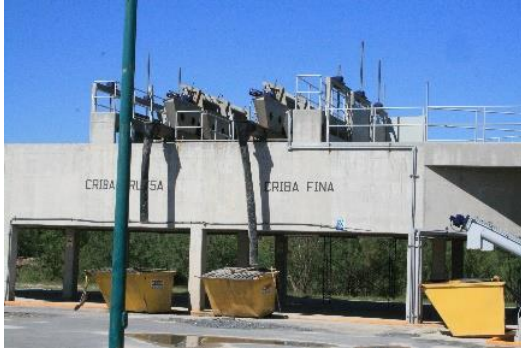
PRETRATAMIENTO DE CRIBADO Y DESARENADO.
