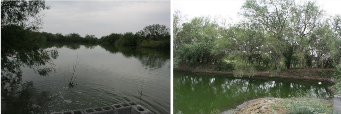
(IZQ) RECORRIDO DE LAS AR EN LA LAGUNA ANAEROBIA. (DER) SE APRECIA LA GRAN CANTIDAD DE VEGETACIÓN SOBRE LOS BORDES Y TALUDES, QUE SEÑALA LA FALTA DE MANTENIMIENTO DE LAS INSTALACIONES.
