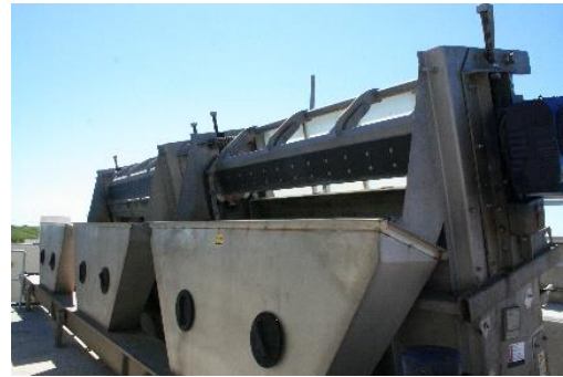
CAJA DE LLEGADA A REJILLAS DE DESBASTE GRUESO
