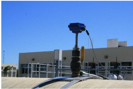
MEDIDOR DEL GASTO INFLUENTE DE AGUA RESIDUAL.
