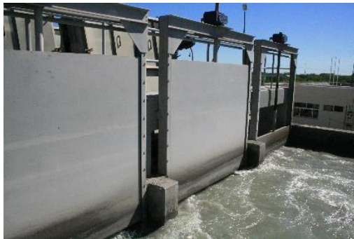
CAJA DE LLEGADA A REJILLAS DE DESBASTE GRUESO
