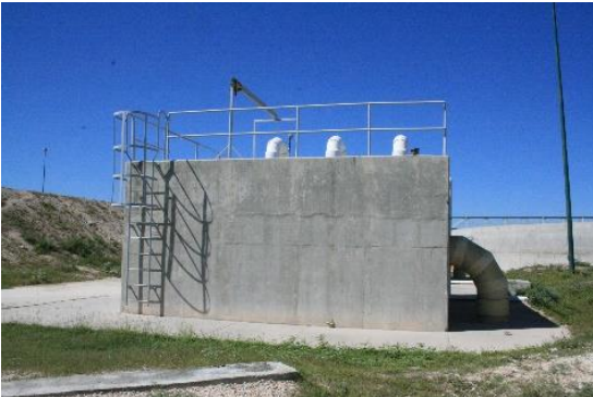
LAGUNA DE DIGESTIÓN AERÓBICA DE LODOS. SE APRECIA LA TUBERÍA DE DESCARGA A LAS LAGUNAS DEL SISTEMA FUERA DE OPERACIÓN.
