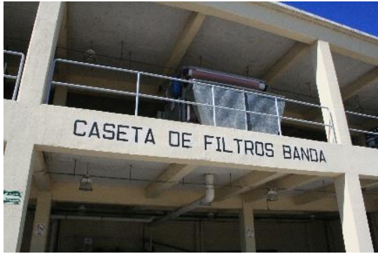
SISTEMA DE DESAGUADO MECÁNICO DE LODOS, MEDIANTE FILTROS BANDA.
