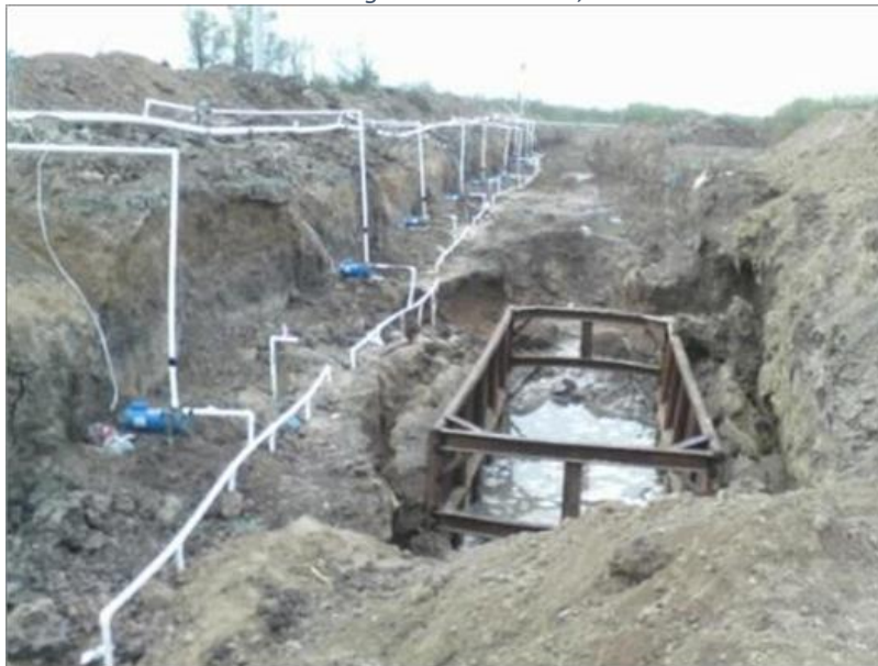
Ilustración90 Colocación de colector marginal en Río Bravo, TM.
