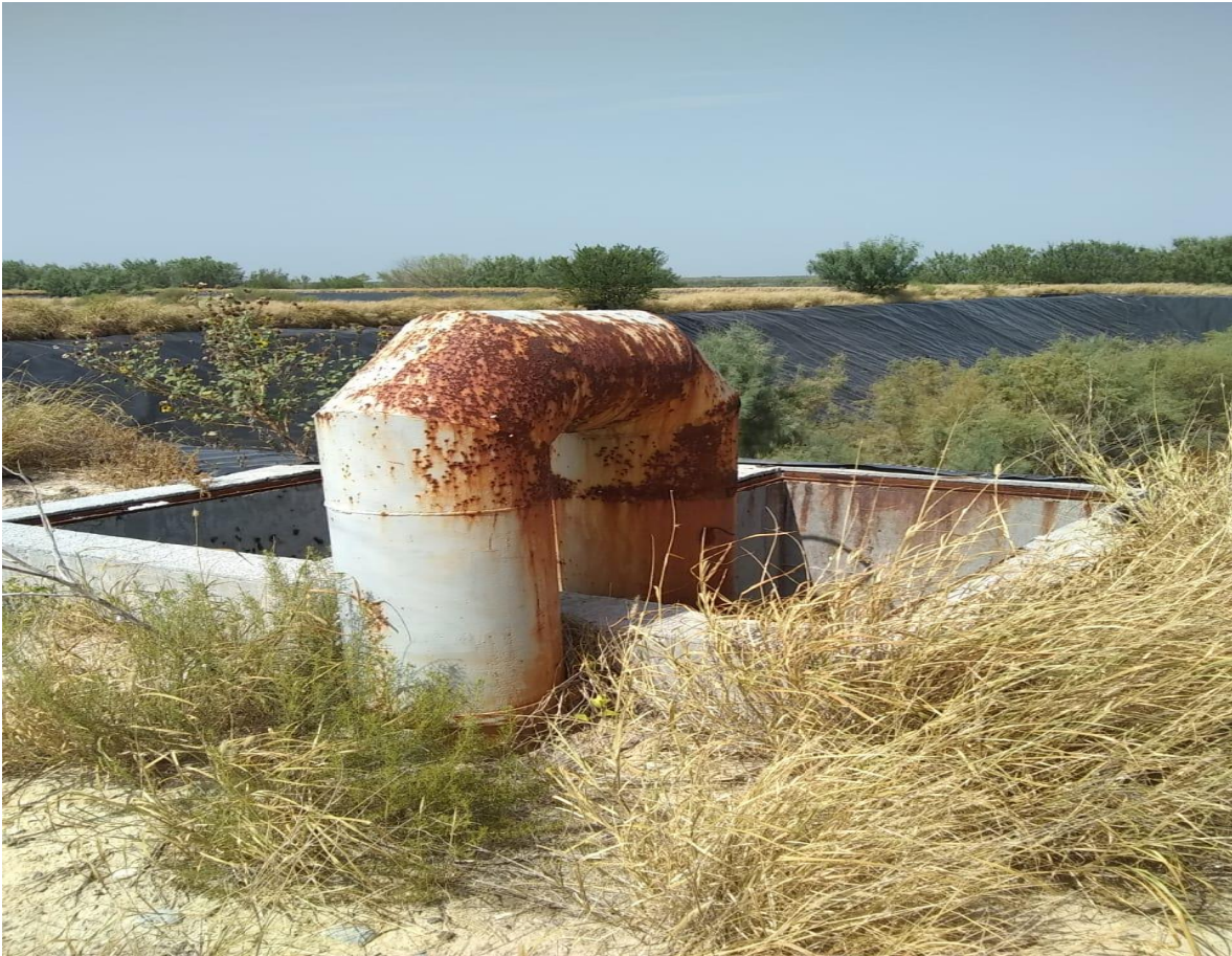
Ilustración49 Llegada emisora caja de recepción entrada a Lagunas, Mier, TM.
