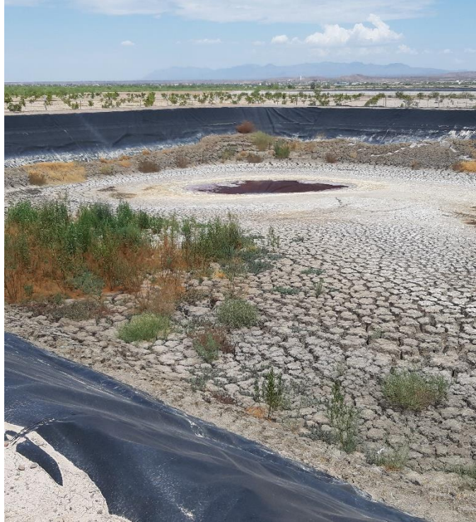
Ilustración 10. Vista general de una Laguna anaerobia requiriendo desazolve.
