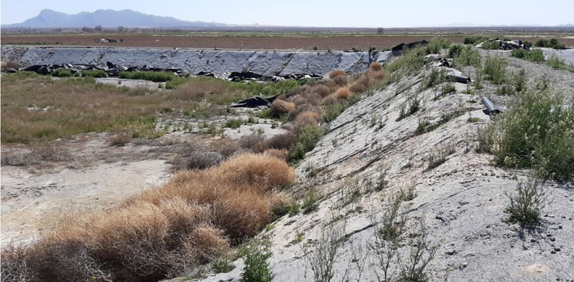
Ilustración24. Vista de una laguna facultativa de la PTAR, mostrando evidente deterioro
