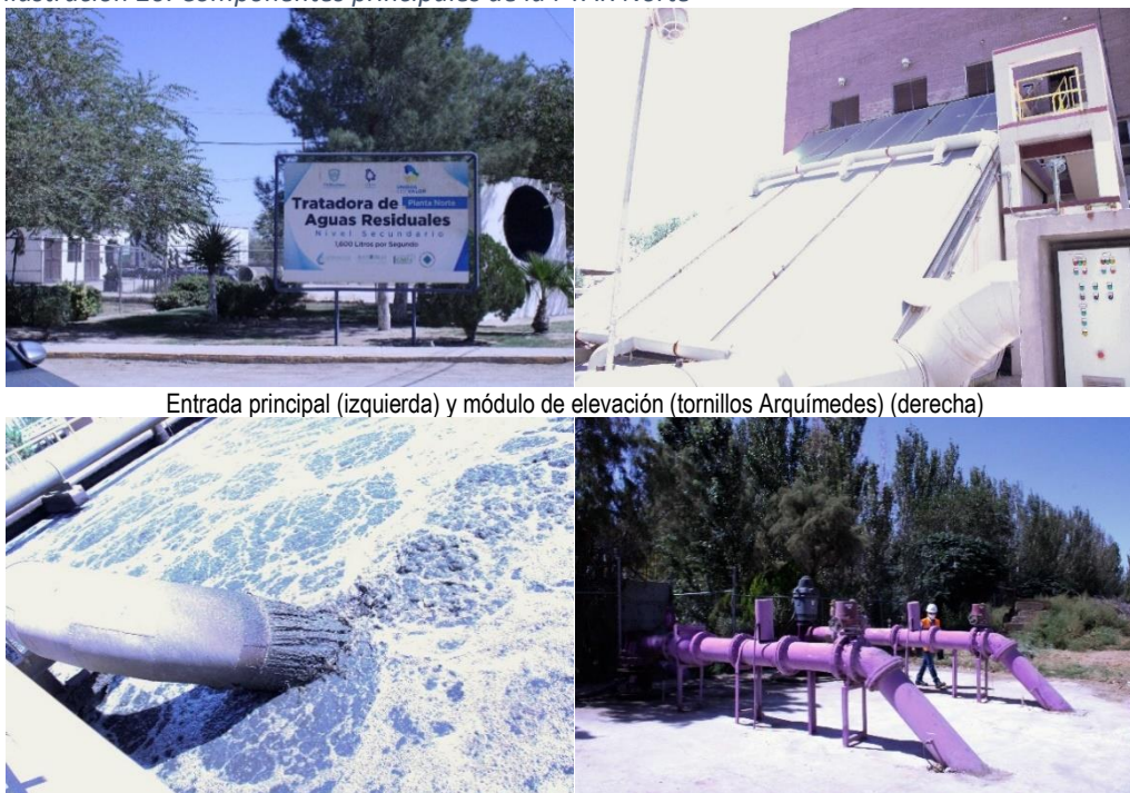
Bioreactor (izquierda). Línea morada (derecha)
