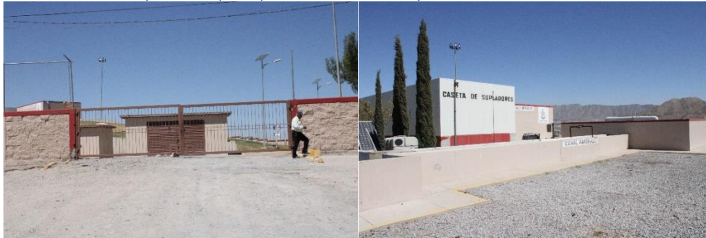
Acceso (izquierda). Caseta de sopladores, canal Parshall y tanque de almacenamiento (derecha)
