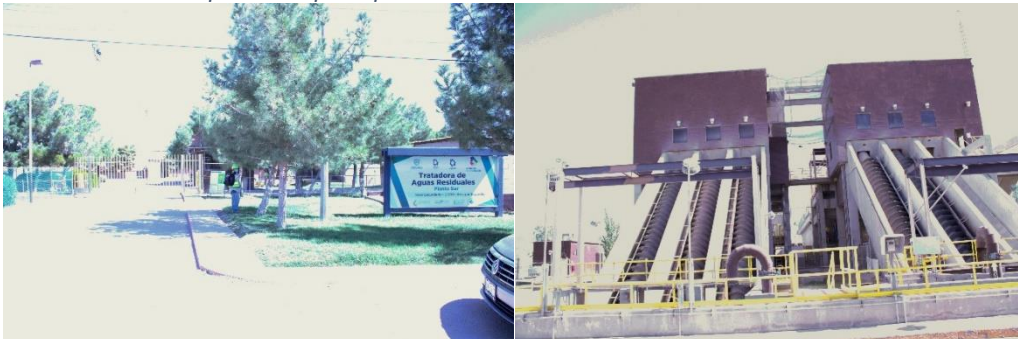
Entrada principal (izquierda) y módulo de elevación (tornillos Arquímedes) (derecha)
