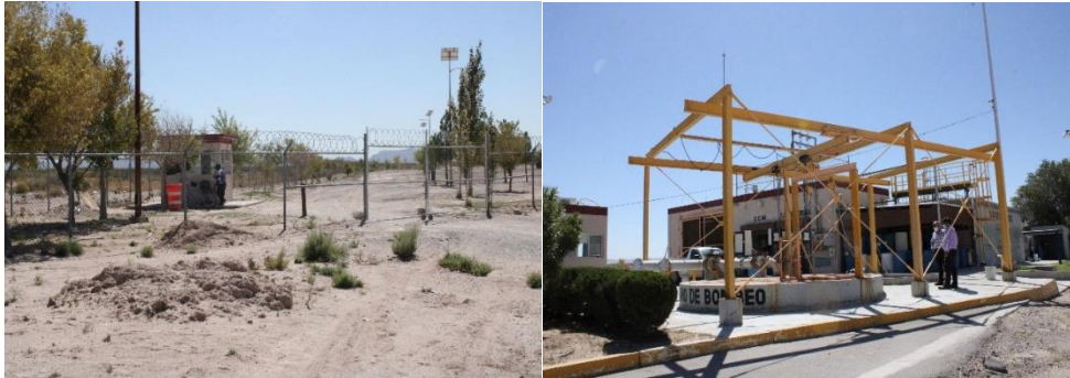
Entrada principal (izquierda) y cárcamo de bombeo (derecha)
