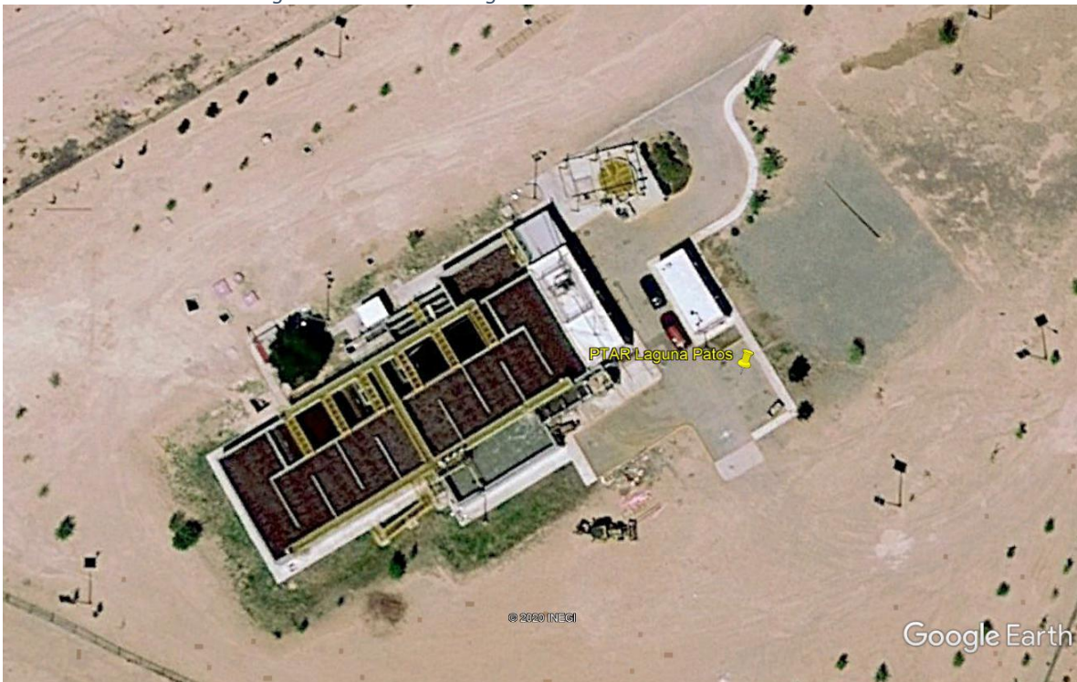
Ilustración 24. Vista general de la PTAR Laguna de Patos
