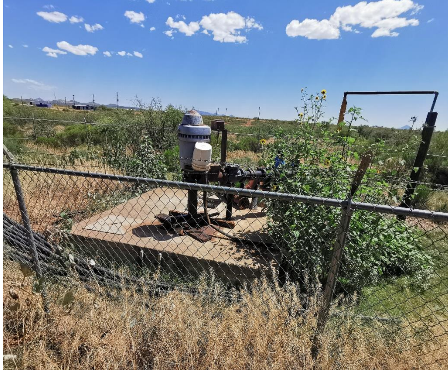
Ilustración 13. Planta de bombeo; envía efluente para reúso de aguas residuales tratadas en riego
