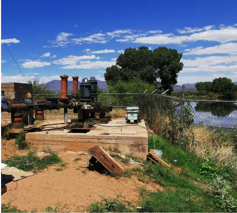
Ilustración 8. Cárcamo de bombeo de la laguna 2 a la laguna 3 (2 equipos de 15 HP)
