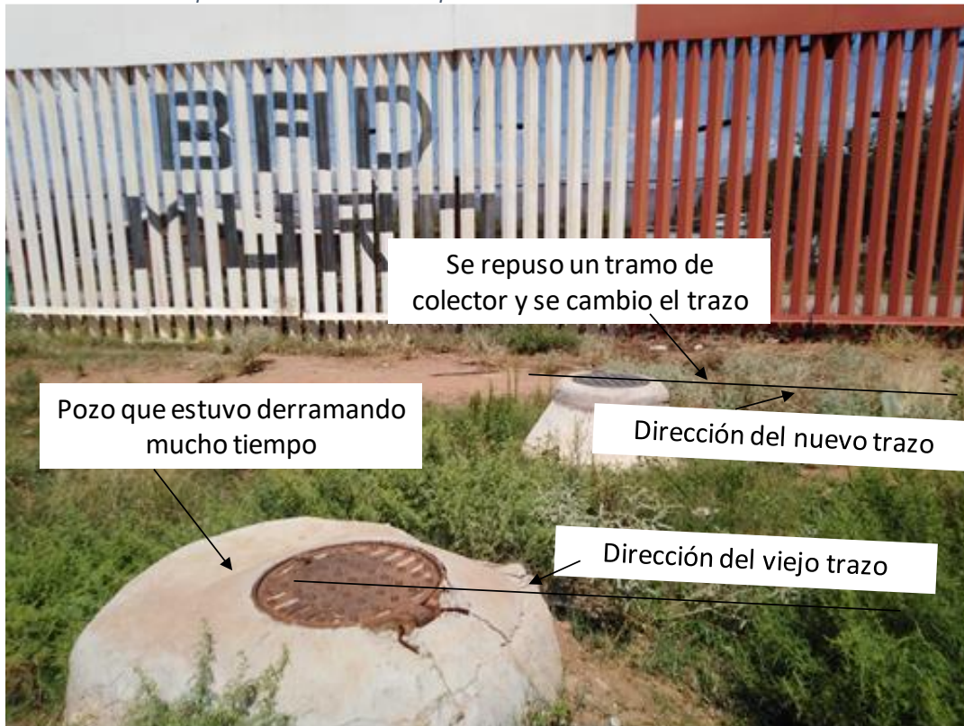
Ilustración 10. Reposición del colector Pesqueira en el tramo de la calle Internacional
