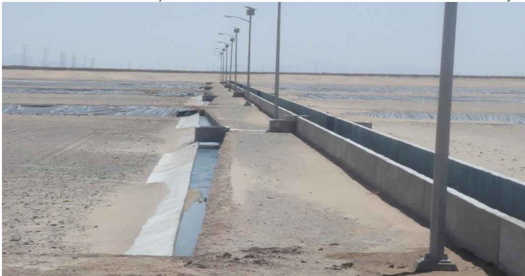
Ilustración 6. Canal central y canaletas vertedoras laterales de alimentación a los lechos de infiltración
