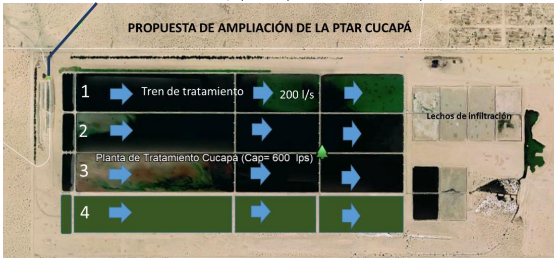
Ilustración 26. Cuarto módulo de 200 l/s para ampliación de la PTAR Cucapah, San Luis Río Colorado
