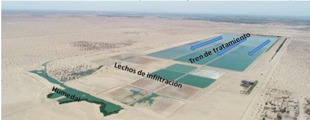
Ilustración 31. Sistema de tratamiento e infiltración del agua residual tratada, PTAR Cucapah, SLRC
