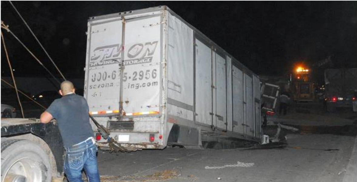
Ilustración 35. Falta de protección en colector Poniente, colonia Arboledas La Mesa, Tijuana, BC.
