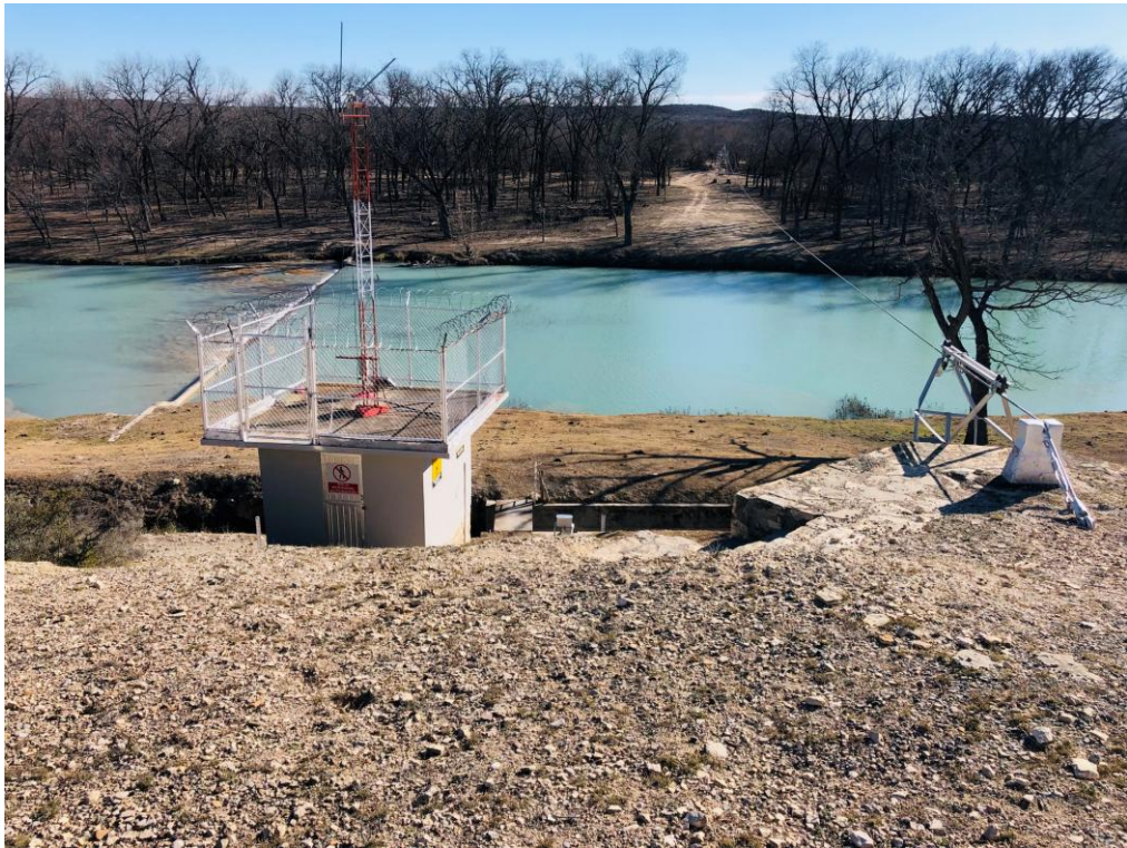
ESTACIÓN HIDROMÉTRICA RÍO SAN DIEGO
