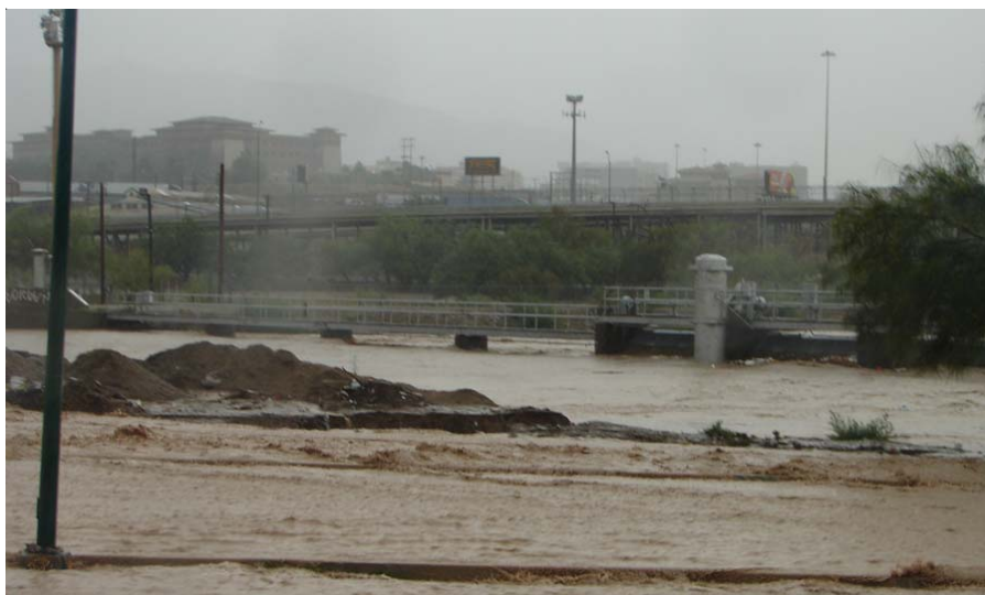
La Presa Internacional en Ciudad Juarez, Chih. - El Paso, Tex. durante la avenida del 1 de agosto del 2006.
