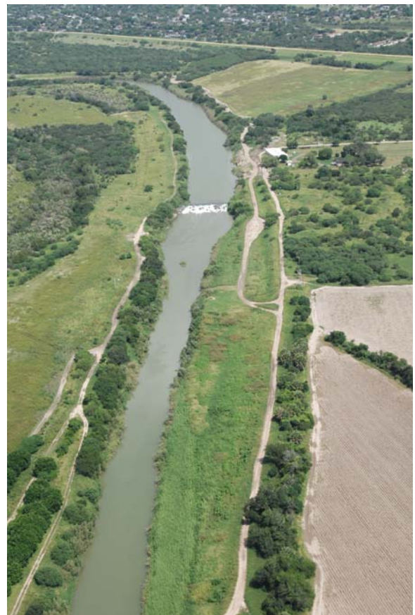
Estación hidrométrica en Brownsville, Proyecto de Control de Avenidas del Bajo Río Bravo
