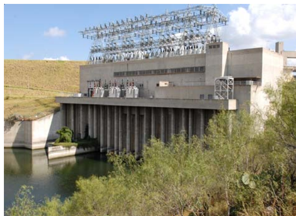
Planta Hidroeléctrica en la Presa Falcón, del lado estadounidense.
