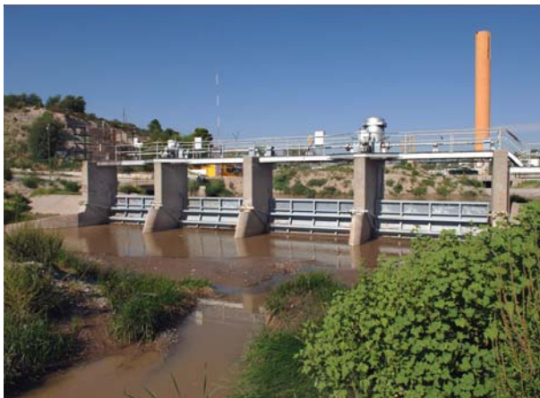
La Presa Internacional deriva agua del Río Bravo para México en Ciudad Juárez, Chih.
