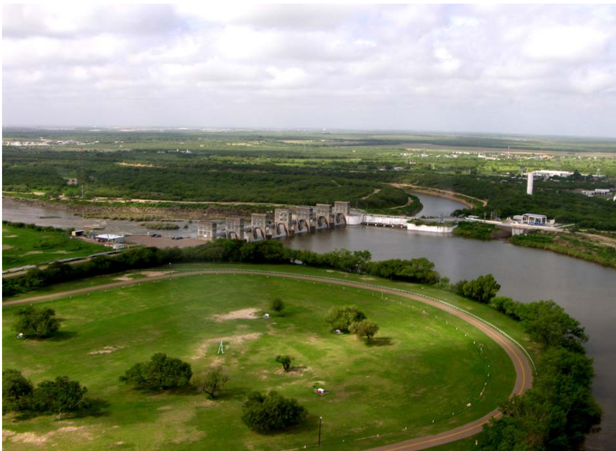
VISTA AÉREA DE LA PRESA DE DERIVACIÓN ANZALDÚAS EN EL BAJO RÍO BRAVO.
