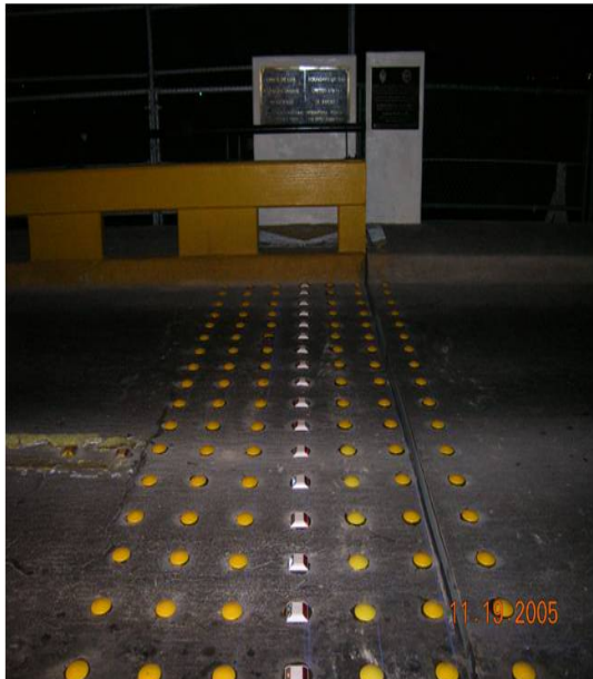
Delimitación de la Línea Divisoria Internacional. Puente de Piedras Negras, Coah. - Eagle Pass, Tex.
