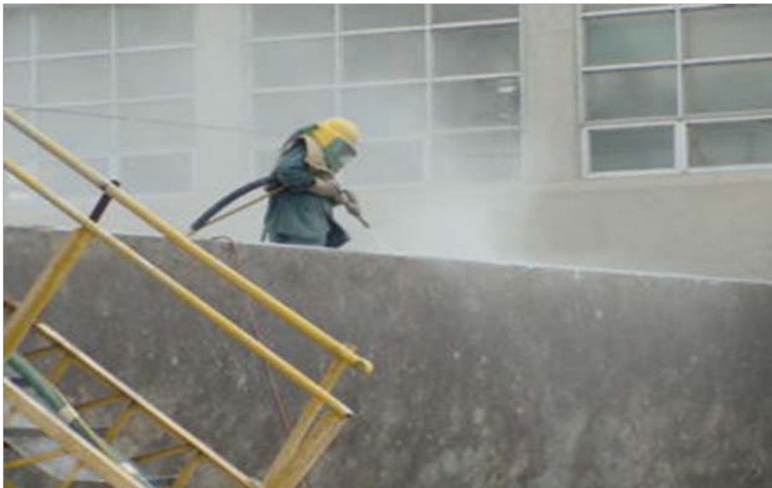
Mantenimiento extraordinario en la compuerta # 1, el cual consistió en limpieza con chorro de arena a presión en la Presa Anzaldúas.
