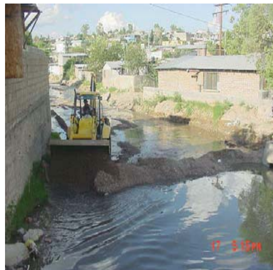
Mantenimiento en el Arroyo Nogales, Son. para el Control de Avenidas.
