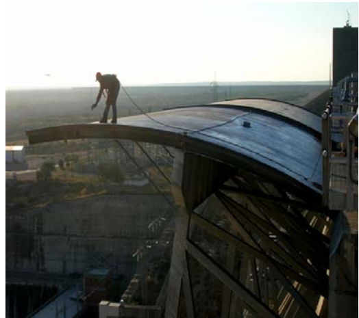
Mantenimiento extraordinario en una compuerta de la Presa Internacional La Amistad en Cd. Acuña, Coah. - Del Río, Tex.
