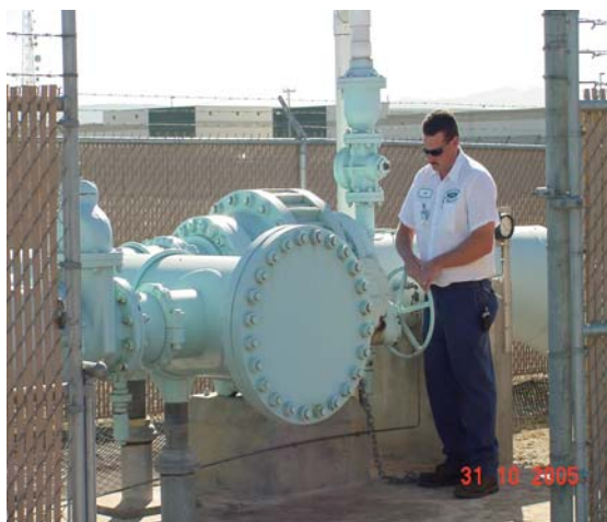
Personal Operando la Conexión de Emergencia para el abastecimiento de agua a Tijuana, B.C.
