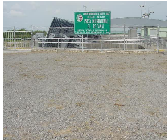
B).- Vista de las compuertas
